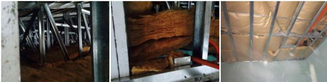
Figura 8 imágenes cubierta edificio. Fuente: Informe de evaluación
